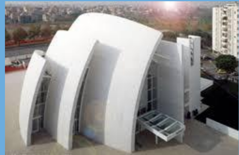
Arch. Richard Meyer – Chiesa di Dio Padre Misericordioso,
